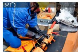
Arbeiten unter Spannung im Niederspan-
