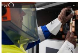
5 Sicherheitsregeln in der Mittelspannung
